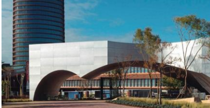
El Centro Caixaforum de Sevilla
